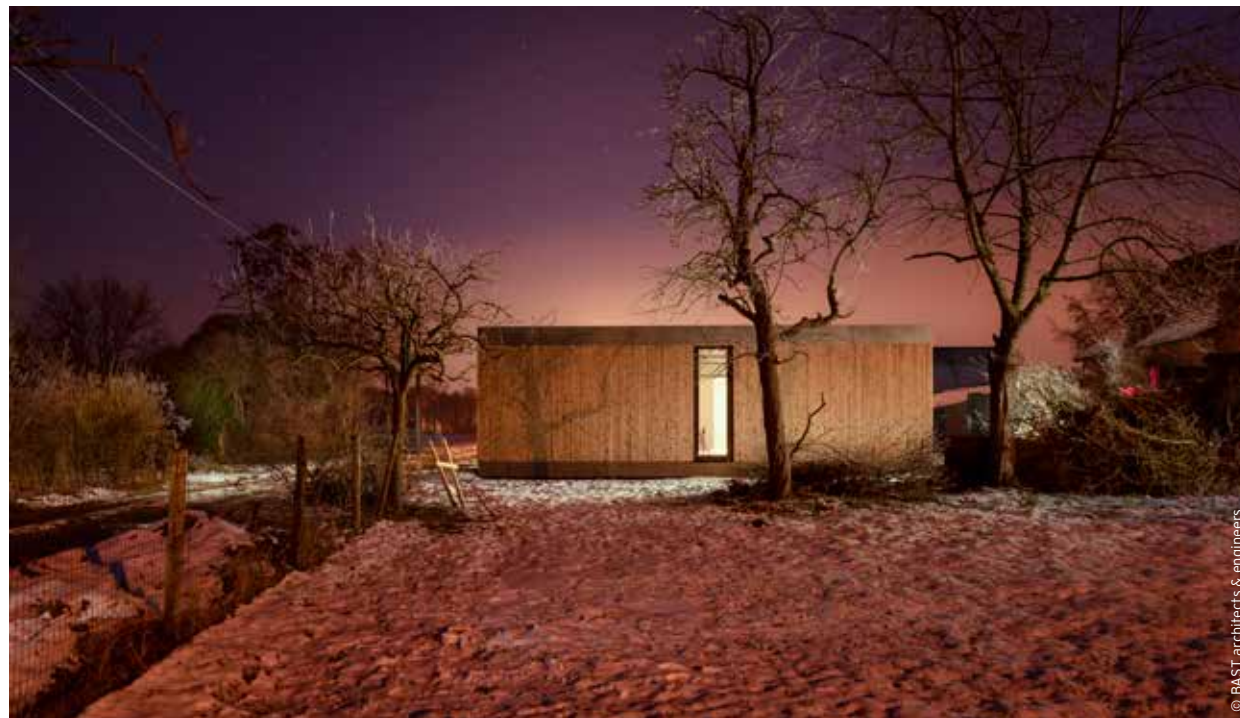
Het Gentse BAST architects & engineers realiseerde een tijdje geleden een zorgwoning in het landelijke buitengebied van Zomergem. Door die ligging kozen ze voor een tijdelijke structuur van geprefabriceerde woonmodules.
