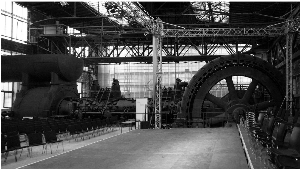
Hattingen : moteur à gaz de haut fourneau actionnant un soufflant et une génératrice d'électricité
