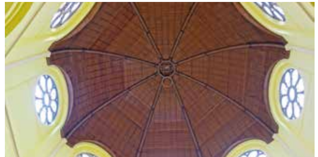
Figuur 15: Sint-Jobskerk. Zicht op het houten gewelf vanaf het schip. (Foto Louis Vandenaabeele)
