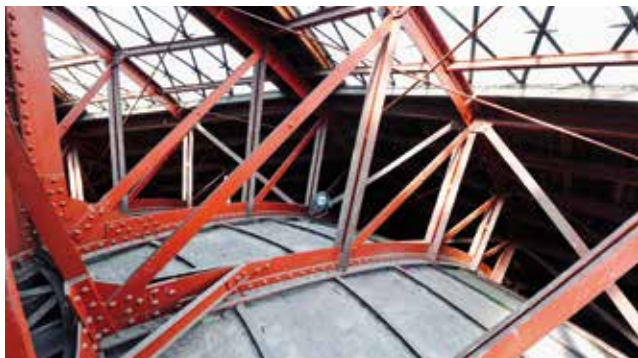
Figuur 7: Sint-Mariakerk. Metalen dakgebinte. (Foto Romain Wibaut)
