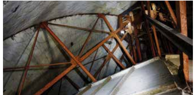
Figuur 13: Sint-Jobskerk. Stalen dakgebinte. (Foto Louis Vandenaabeele)
